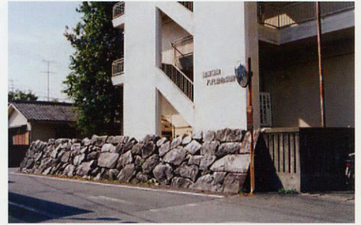
④二之丸石垣跡
